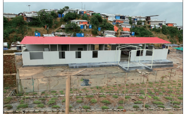
外観が出来上がりつつある診療所(2019年8月撮影)
